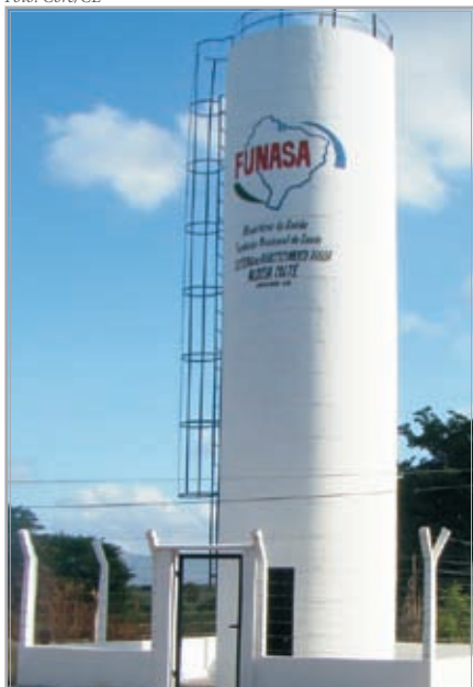
Sistema de abastecimento de água da aldeia de Coité
