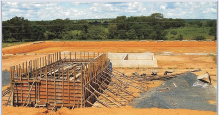
Funasa constrói estação de tratamento de esgoto no município de São Romão: saúde e desenvolvimento
